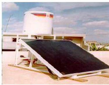
Le chauffage solaire de l'eau est l'un des usages les plus répandus en Tunisie. La technologie du chauffe-eau solaire (CES) est aujourd'hui techniquement et commercialement mature, et convient parfaitement au consommateur tunisien.
